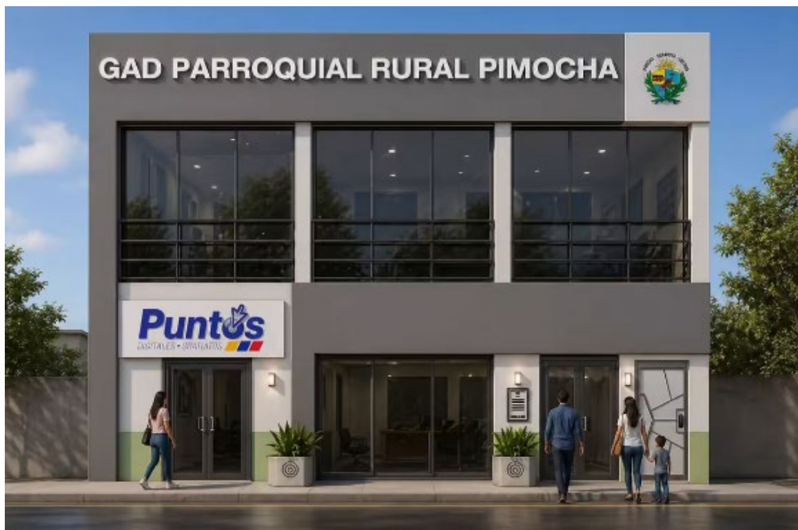
Reconstrucción del Edificio Parroquial.
